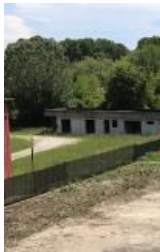
Edifici Area Veritas
