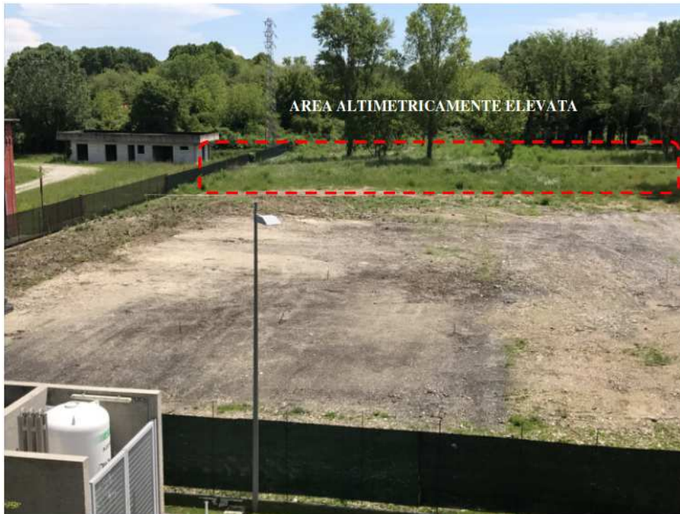
Fig. 24: area di cantiere vista dal lato NO
